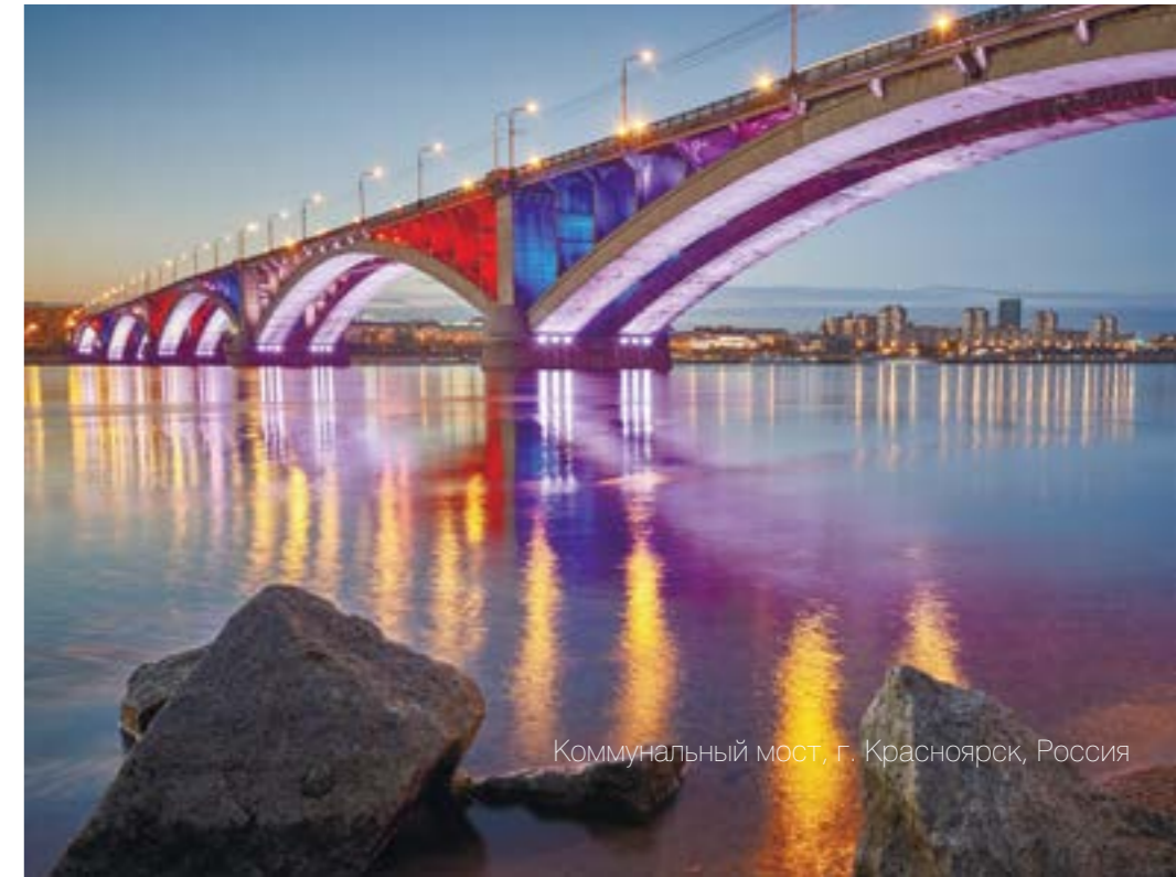
Коммунальный мост, г. Красноярск, Россия
